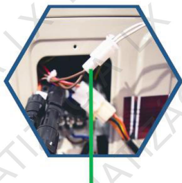
PRIPOJENIE 12 V AC KÁBLA K VONKAJŠEJ JEDNOTKE
